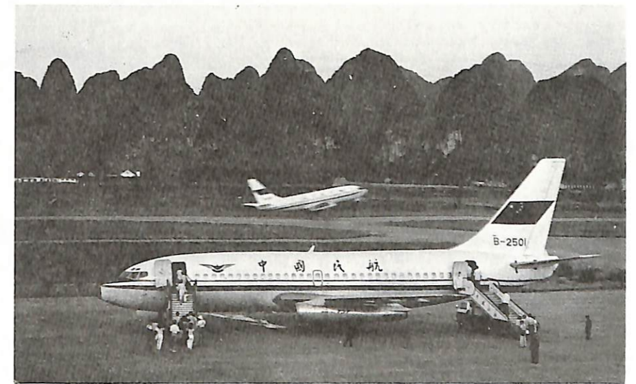
桂林机场 Guilin Airport
